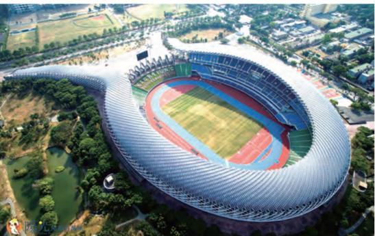
▲高雄國家體育場在屋頂設置8800片太陽能光電板，每年發電量可達114萬度，約可以減少二氧化碳660萬噸的排放量。 工研院
